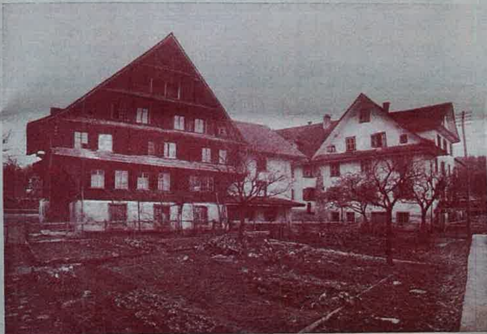
Die beiden alten baufälligen Armenhäuser in Immensee
